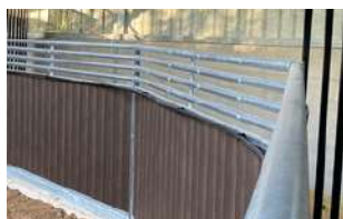
Clôture résine avec réhausse tubes
