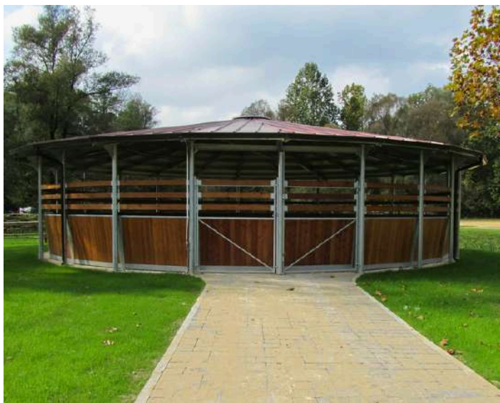
Rond de longe avec toiture isolée
